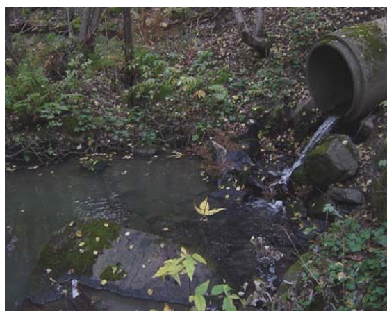
Figur 24. Bergendalsbäcken: Från kulvertmynning i den övre delen av den undersökta lokalsträckan.
